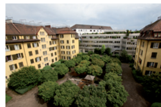
Kamera nach unten gerichtet: Die vertikalen Linien werden verzogen.
