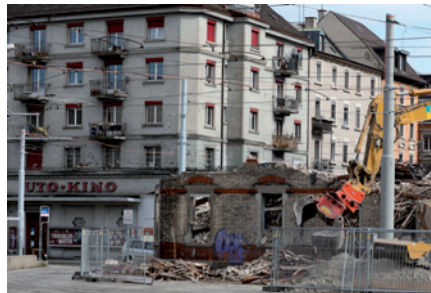
Aufgenommen weiter hinten mit Brennweite 100 mm: Abbruchhaus ca. gleich gross, Hinter- grund deutlich grösser.
