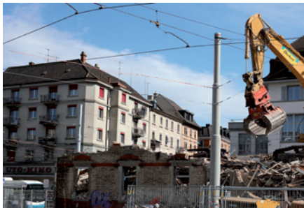
Aufgenommen mit Brennweite 50 mm: Abbruchhaus im Vordergrund grösser, Häuser im Hintergrund kleiner.
